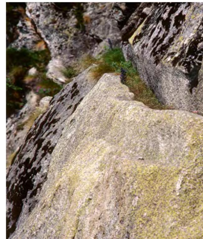
Bisses du Niwärch (à gauche), Baltschiederthal et de l'Oberschta (à droite), Gredetschtal: les ouvriers creusent le bisse en chenal ou en encoffrement dans le rocher, à la masse et au burin. Un véritable travail de fourmi car l'explosif n'existe pas encore. La largeur de ces sections détermine le débit de chaque bisse
