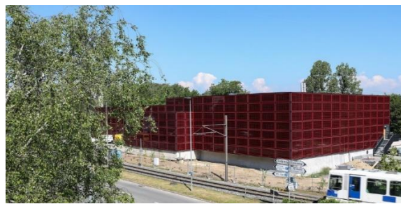
La centrale thermique et Data Center du campus
