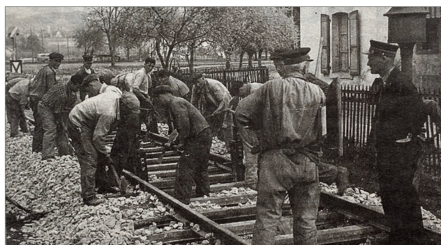
Été 1942. Changement de rails et de traverses sur la voie Payerne-Cugy FR sous le regard du gardien du passage à niveau
