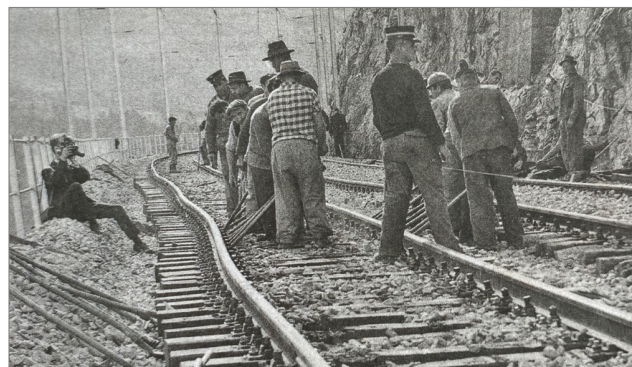
Sur la ligne du Lötschberg dans les années 30, il était temps de procéder à l'ajustement des voies et du ballast...
