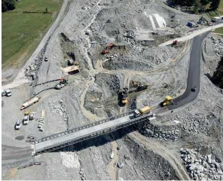
Le pont provisoire posé par l'Armée permettant de relier Champsec à Lourtier.
