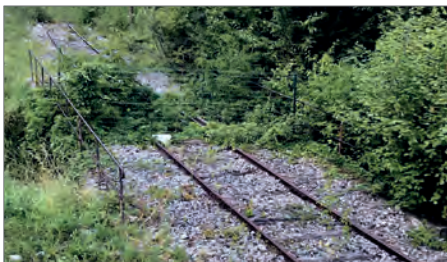
Le projet est déjà prêt à être défriché!
