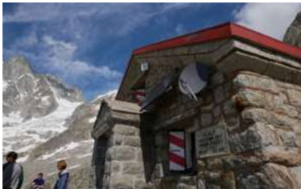
Rénovation A Neuve
