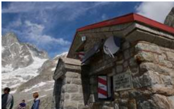
Rénovation A Neuve
