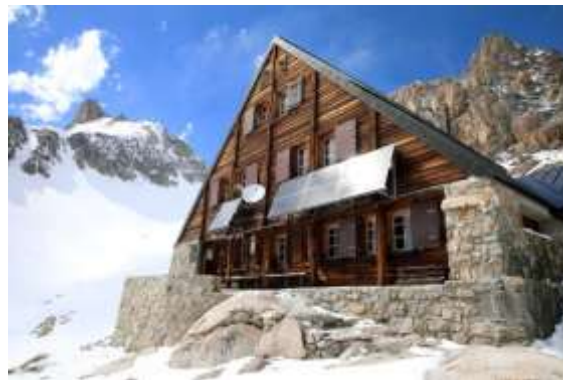
Concours rénovation Orny (chantier 2028)
